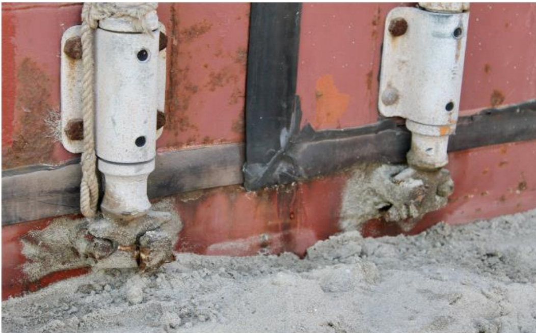
Figuur 30: Het sluitingsmechanisme zit zowel aan de boven- als onderkant van de deur
